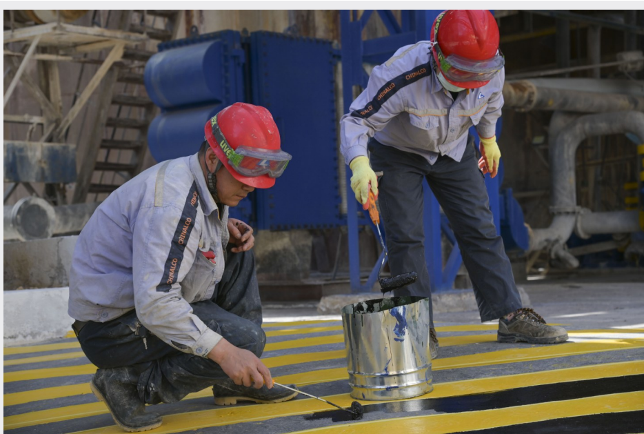
▲为进一步优化现场环境,打造安全、绿色、和谐的工作场所,中铝山东氧化铝厂组织员工开展现场治理,为冲刺“双过半”提供坚强保障。图为该厂员工重新粉刷地面警示线。
