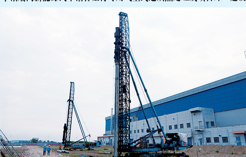
▲图为项目开工现场。
