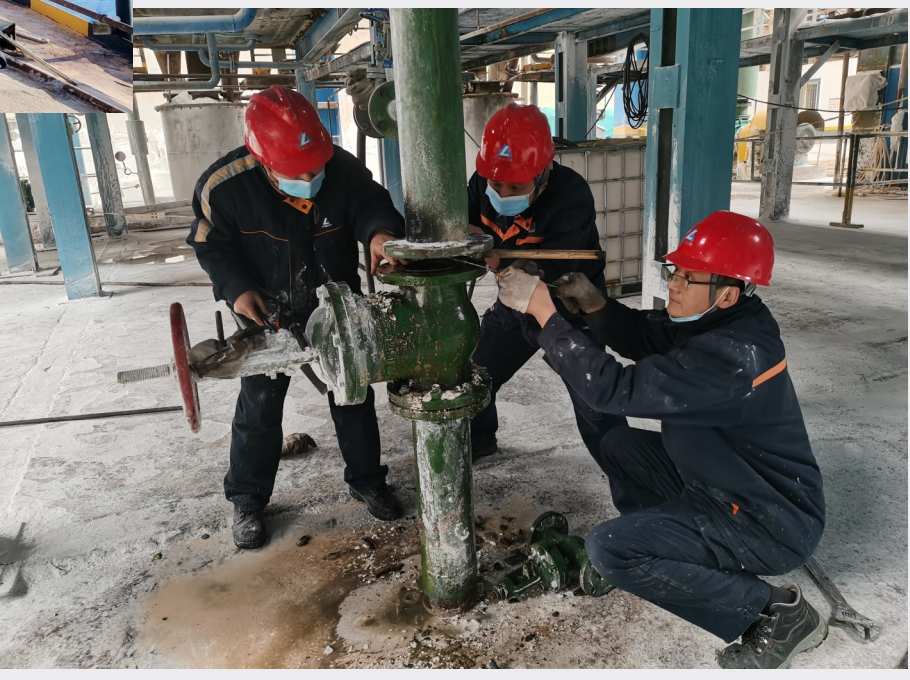
为圆满完成中铝矿业氧化铝铝百吨降本目标任务,4月17日,中铝矿业生产管控中心蒸发焙烧工序利用E组管道化倒组的停机时机,对长期运行的焙烧炉流化床进行了清理排渣及检修处理,有效提高了流化床的运行效率,为实现降本任务作出了积极贡献。图为中铝矿业生产管控中心蒸发焙烧工序岗位职工检修流化床管道阀门。 焦留军 摄影报道
