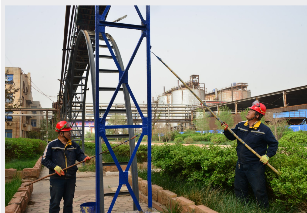
近期，中铝山东氧化铝厂深入践行绿色发展理念，大力开展现场绿化、管道支架防腐工作，持续提升现场管理水平，打造花园式工厂。图为岗位人员对管道支架进行防腐处理。李丙莲 摄影报道
