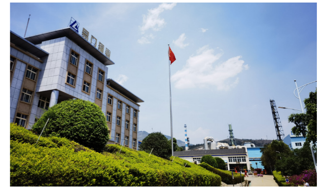
易门铜业建成生产污水和生活污水处理站，实现水资源 100% 循环利用
