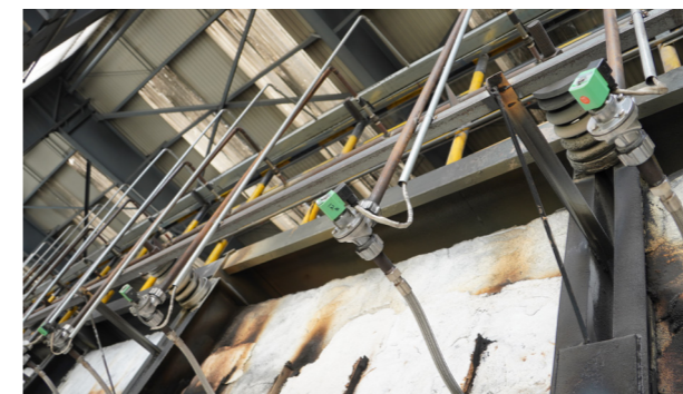
抚顺铝业自主设计“煅烧炉挥发分大道智能清灰装置”
