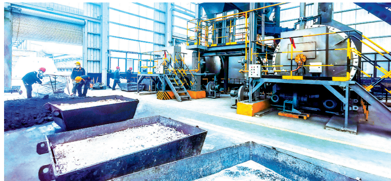
云铝海鑫 7000 吨炭渣资源化利用项目投入运行
