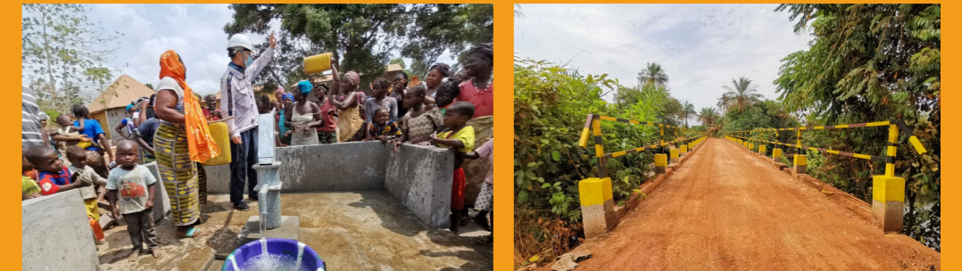
中铝几内亚为博法市福贡村打井，水井水质达到饮用标准 中铝几内亚支援基础建设，修复巴克洛桥梁
